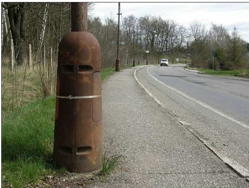
F34 – chodník před rekonstrukcí
